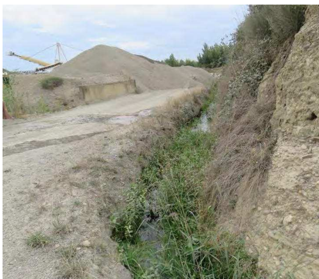
Fossé présent sur le site de la carrière actuelle (au niveau de l'aire de stockage sud-est)
