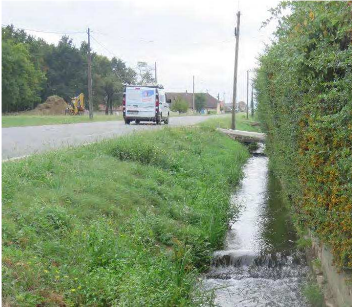
< Exemple de canalet (en bordure de RN21)
